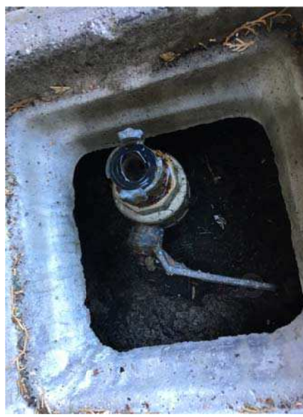
FOTO 4 – TUBAZIONE ESISTENTE IDRICA in pozzetto esistente in prossimità dell'ingresso atleti al campo da gioco "Per derivazione fredda per la nuova palazzina"
