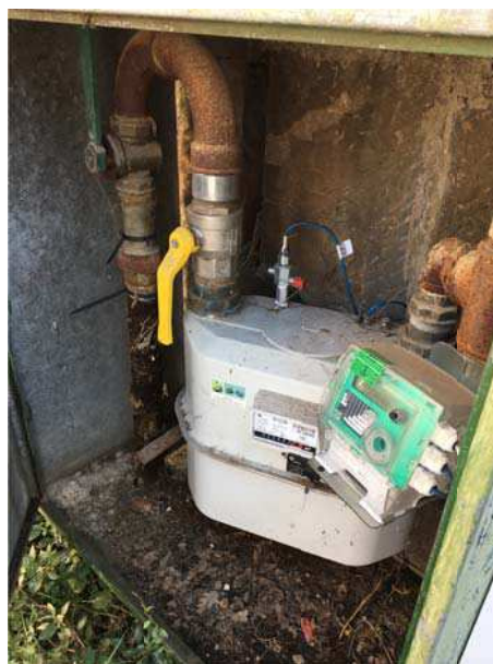
FOTO 2 – CONTATORE FISCALE GAS METANO Dentro armadio metallico aerato "Contatore e derivazione stradale da spostare"
