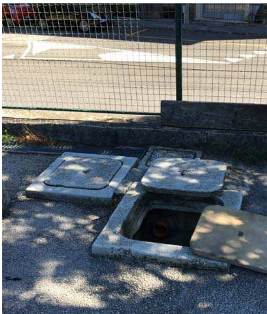
FOTO 5 – POZZETTO ESISTENTE PER SCARICHI
