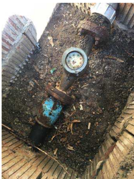
FOTO 3 – CONTATORE FISCALE IDRICO in pozzetto sul marciapiede stradale fuori l'area in concessione "Fornitura idrica esistente da mantenere"
